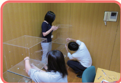
工事前に今まで展示していたエントランスのクリアパネルを解体♪
