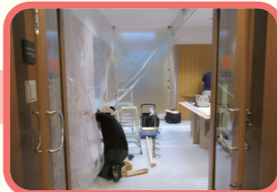
施設にキズをつけないよう養生をしっかりと行います
