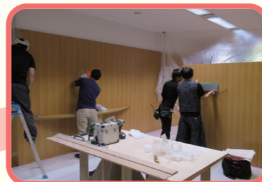
各分野の担当者が着々と工事を進めていきます
