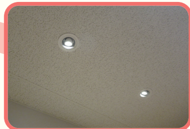
照明も LED に更新しました
